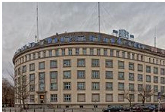
Bývalá budova rozhlasu RIAS, nyní sídlo Deutschlandradio Kultur
